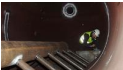
Wnętrze odgazowywacza po modernizacji
