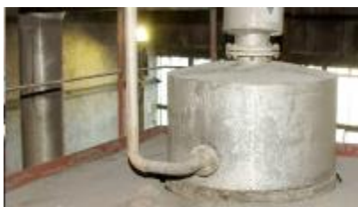
Doprowadzenie wody do odgazowywacza przed modernizacją
